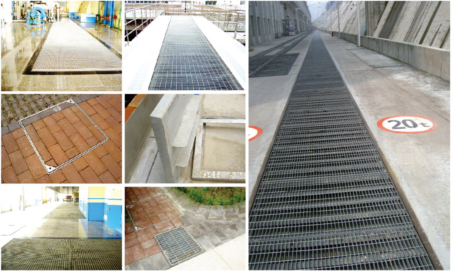
三峡电厂工作场通道
