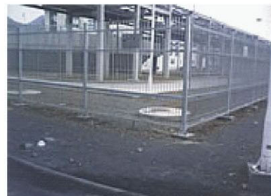
钢格栅板围墙，用于电厂、钢厂、设备安全防护等场
