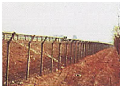
用于高速公路、铁路全封闭护栏网、隔离栅
