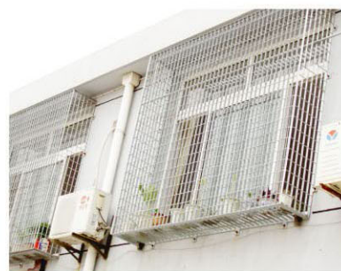
钢格栅板防盗窗，适用于二层以上窗台的防盗、防坠落及延伸晒台
