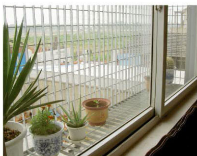
钢格栅板防盗窗，适用于向阳窗台的防盗、防坠落
